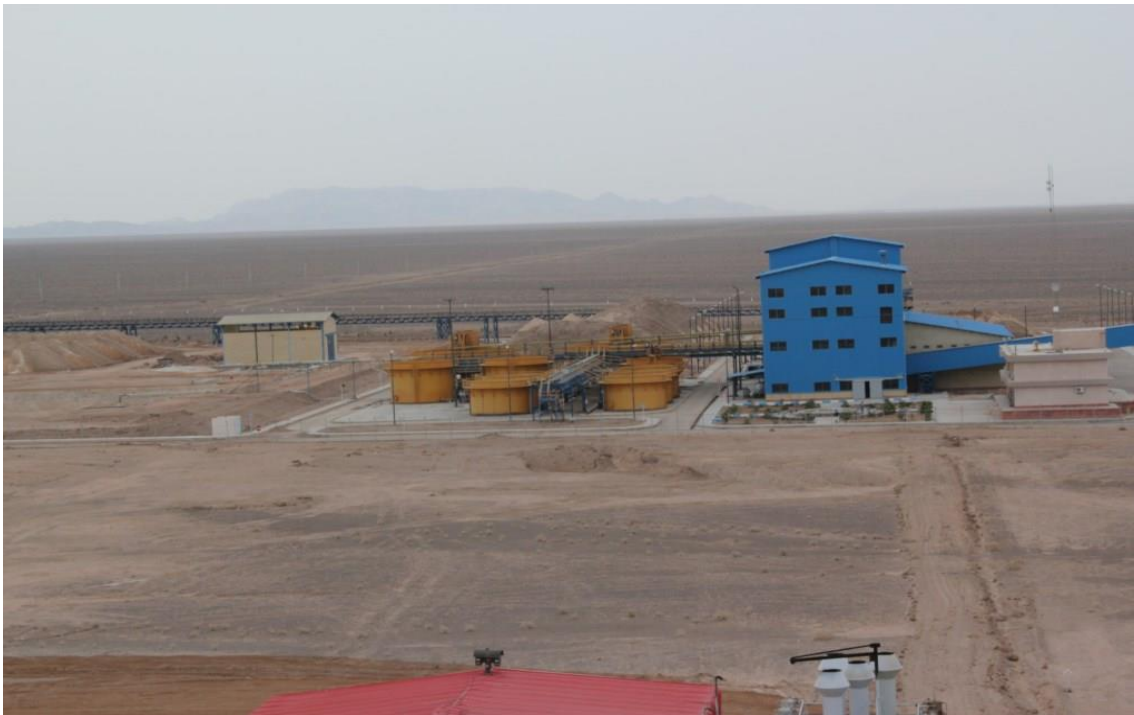
(شکل ۱-۱) نمایی از کارخانه فرآوری مجتمع پتاس خوروبیابانک
